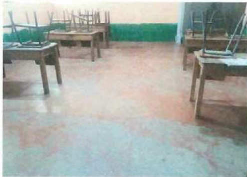
Foto 1: Reparación de piso de aula número 1, colocación de piso cerámico
