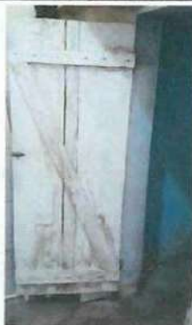
Foto 3: Cambio de puertas de los baños
