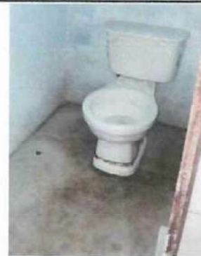
Foto 4: Cambio de inodoro
