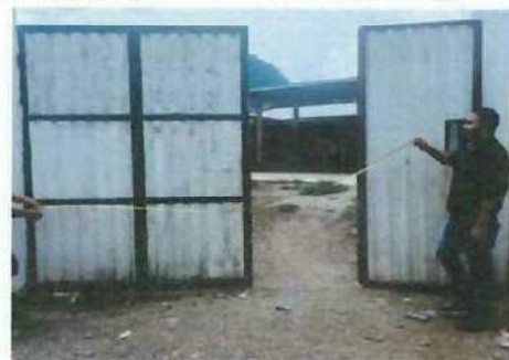
Foto 6: Reparación del porton principal
