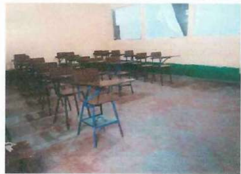
Foto 2: Reparación de piso de aula número 2, colocación de piso cerámico
